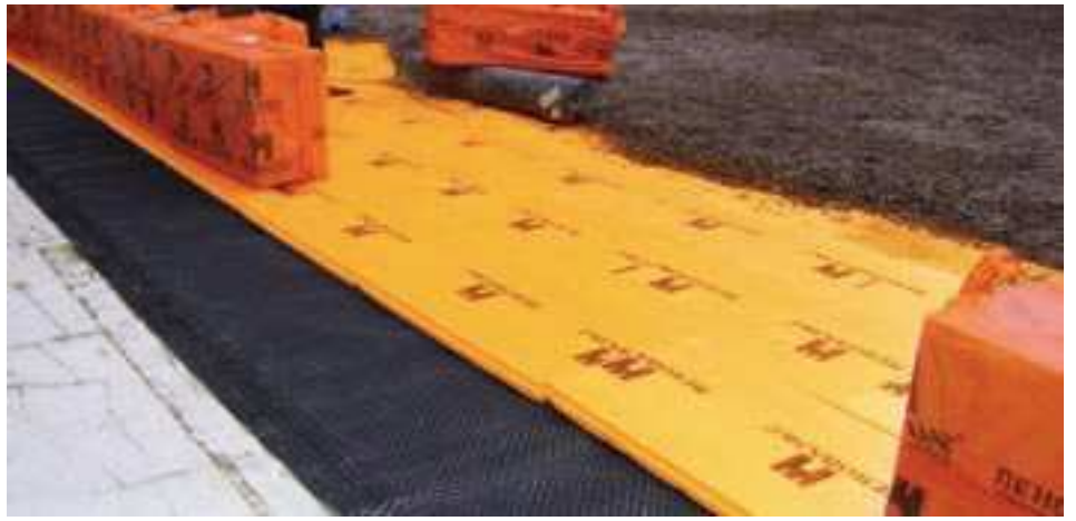
(照片) 倒置式上人屋面，聖彼得堡《波羅地海珍珠》工程項目
