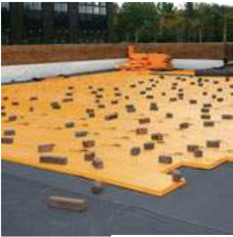
(照片) 倒置式上人屋面，聖彼得堡《波羅地海珍珠》工程項目
